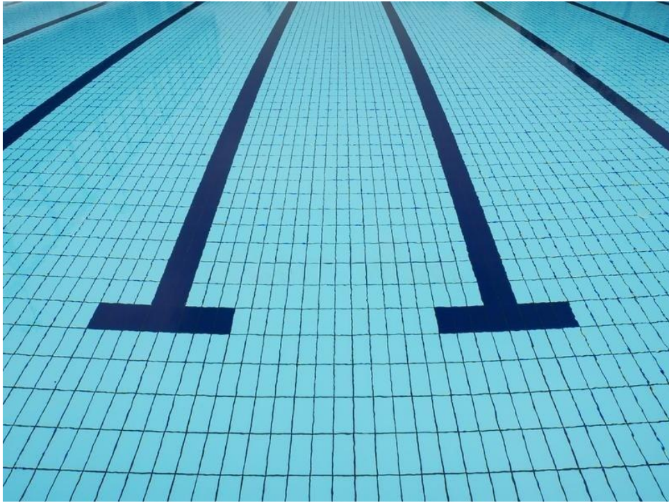
Image 4 : Fond de la piscine avec les lignes bleues foncées.
