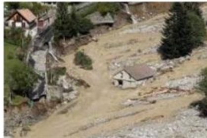
Fig. 1 : Vesubie 2020 (dix morts, huit disparus, des maisons dévastées, des routes emportées par les eaux, des ponts détruits et des centaines de sinistrés)
